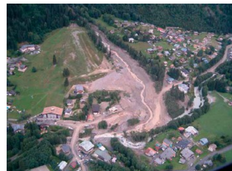
Vue aérienne de la lave du nant d'Armancette sur le cône de déjection dans le secteur de Cugnion (source : RTM74)
