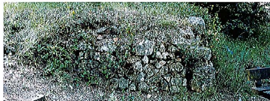
Muret en pierres
