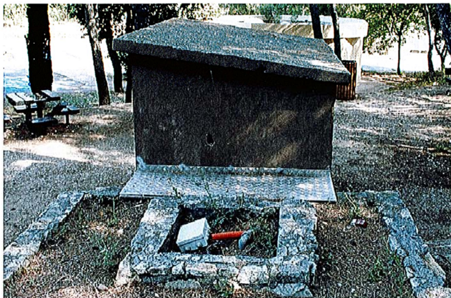
Le forage existant
