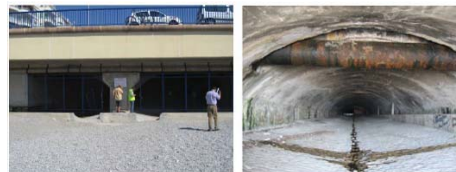
Figure 2.1.7.A – débouché de l'ouvrage hydraulique de Magnan sous la Promenade des Anglais.
