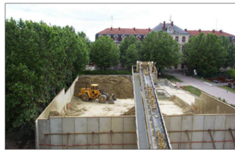
Exemple d'une aire de stockage de déblais
