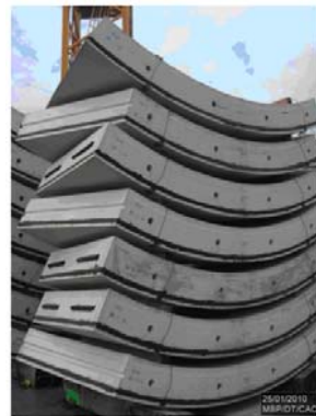
Illustration du stockage de voussoirs pour la réalisation du tunnelier
