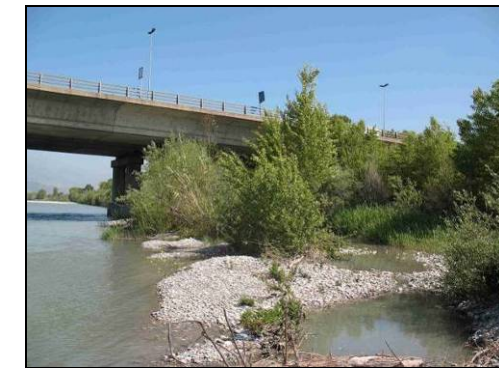
Ripisylve et bancs de galets du Var
