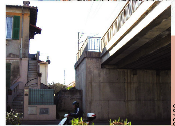
Vue du PRA côté voie 2
