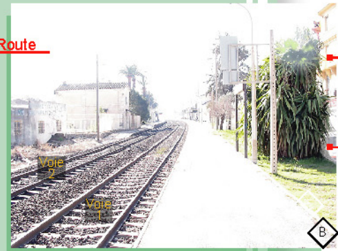
■ Vers MARSEILLE - Quai côté voie 1
