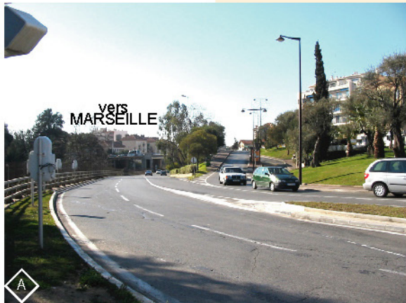
RN 7 longeant la voie ferrée côté voie 1 entre le Pk 203900 et le Pk 204151
