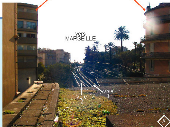
● Entrée de la tranchée couverte située au Pk 192.100
