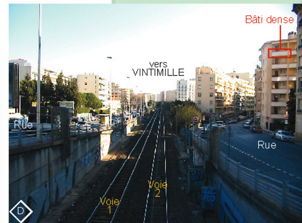
● Sortie de la tranchée couverte située au pK 194.270
